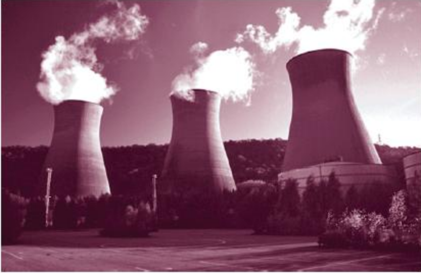
Doğal Akışlı soğutma kulesi.
