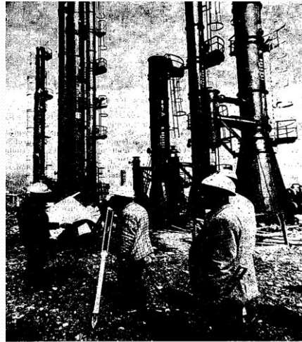
Petrokimya Fabrikası inşaatından bir görünüş
