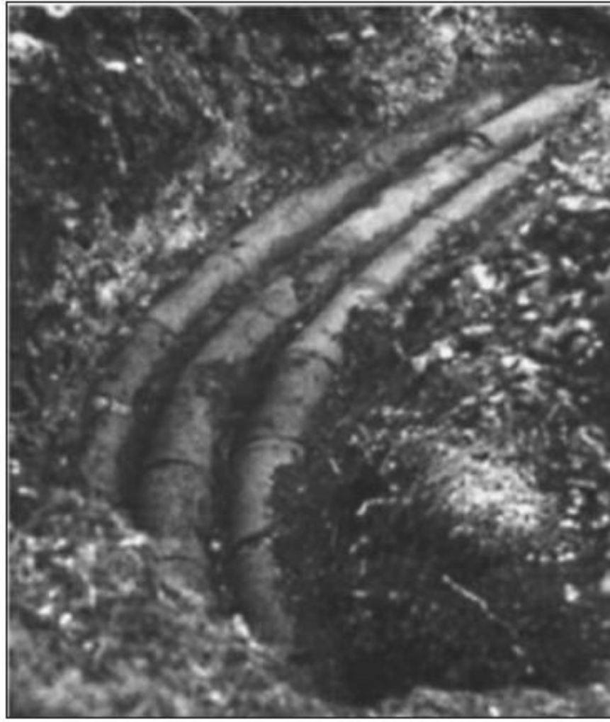
Bergama boru hattının bir parçası. Kilde yapılmış boruların çapları 13-18 cm dir
